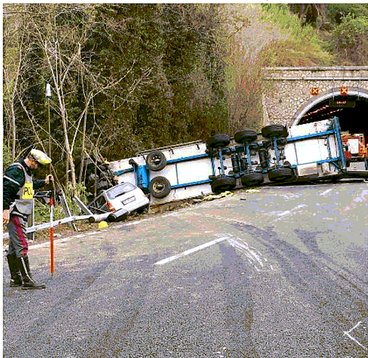
IRILIEVI Il tir ribaltato dopo essere finito contro il cantiere sull'autostrada A10 (Ansa)
